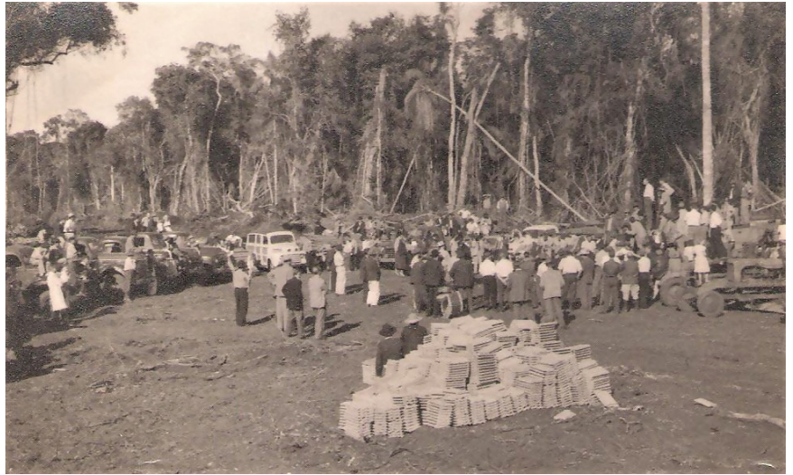
Pedra Fundamental da primeira Capela - 1951
