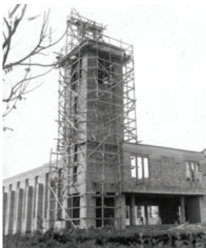
Atual templo, em construção
