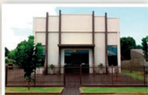
Congregação Quatro Pontes Rua Padre Aloisio Balmeistre, 1110
